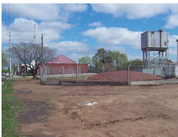
Tanque de alimentación de agua y cisterna.
