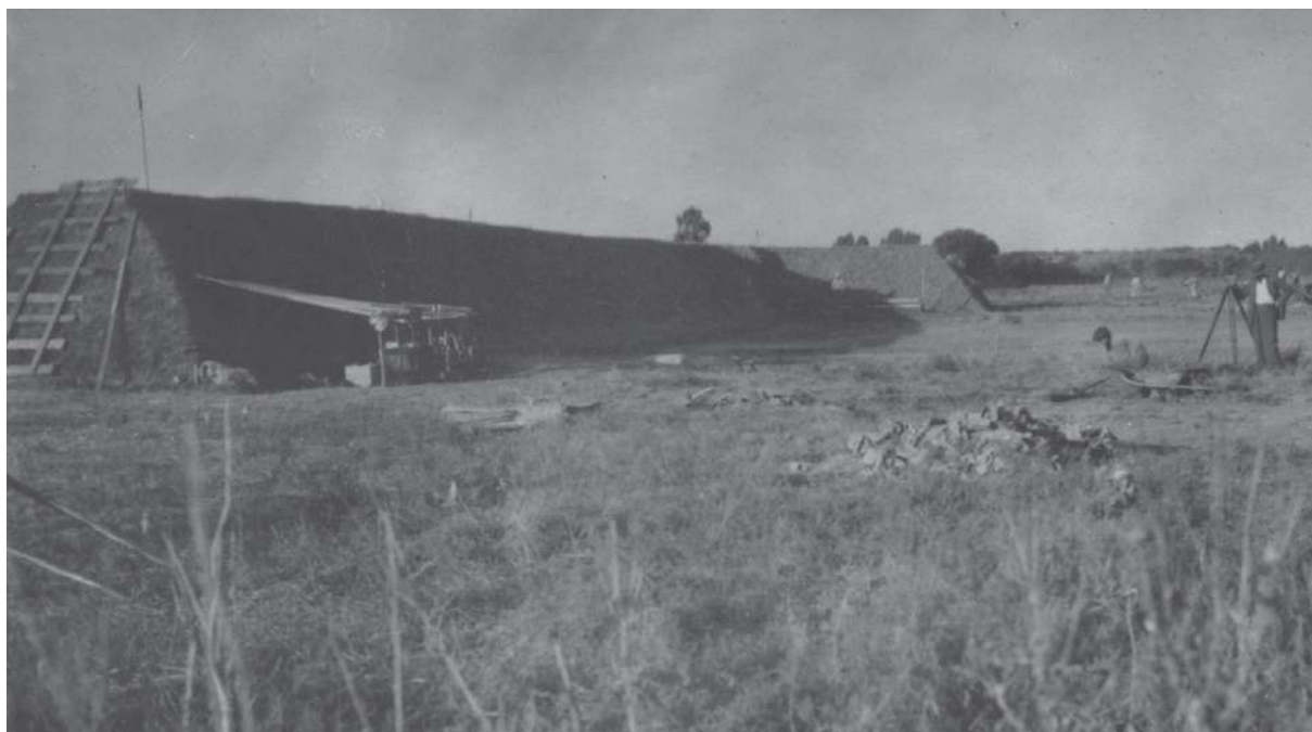
Construcción del talud de contención que rodeaba al Tiro Federal.
