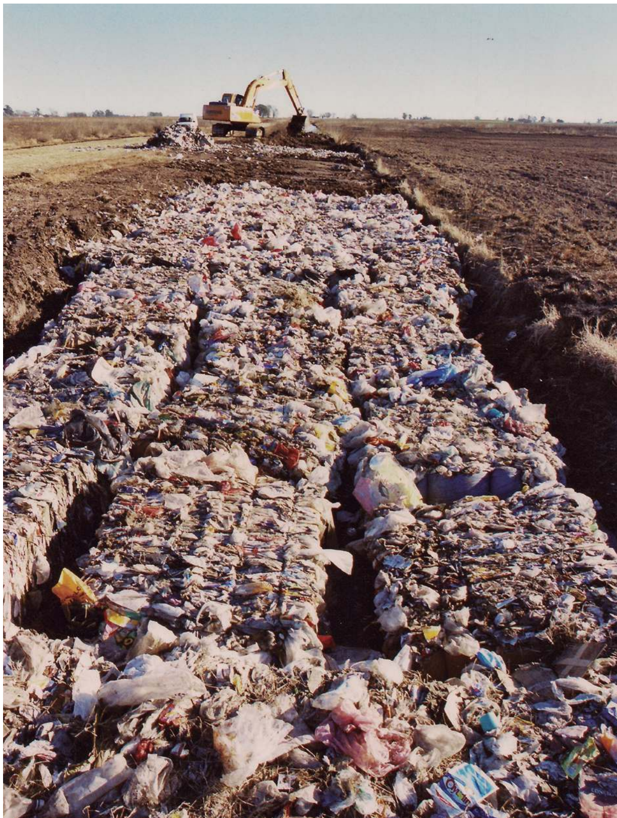
Ampliación de camino en el aeródromo con relleno con residuos plásticos.
