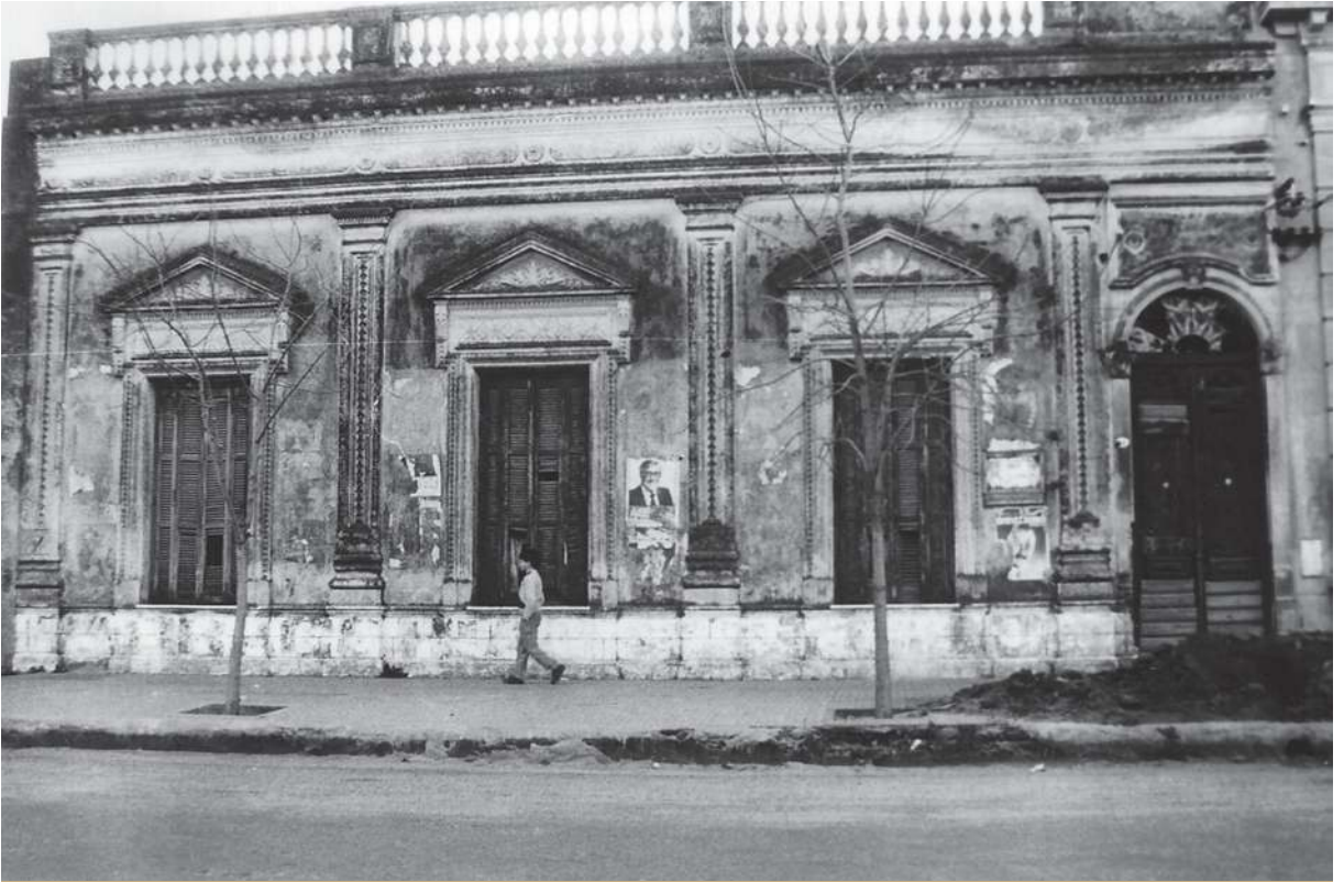
Fachada de la vivienda que hoy ocupa la biblioteca del Poder Judicial.
