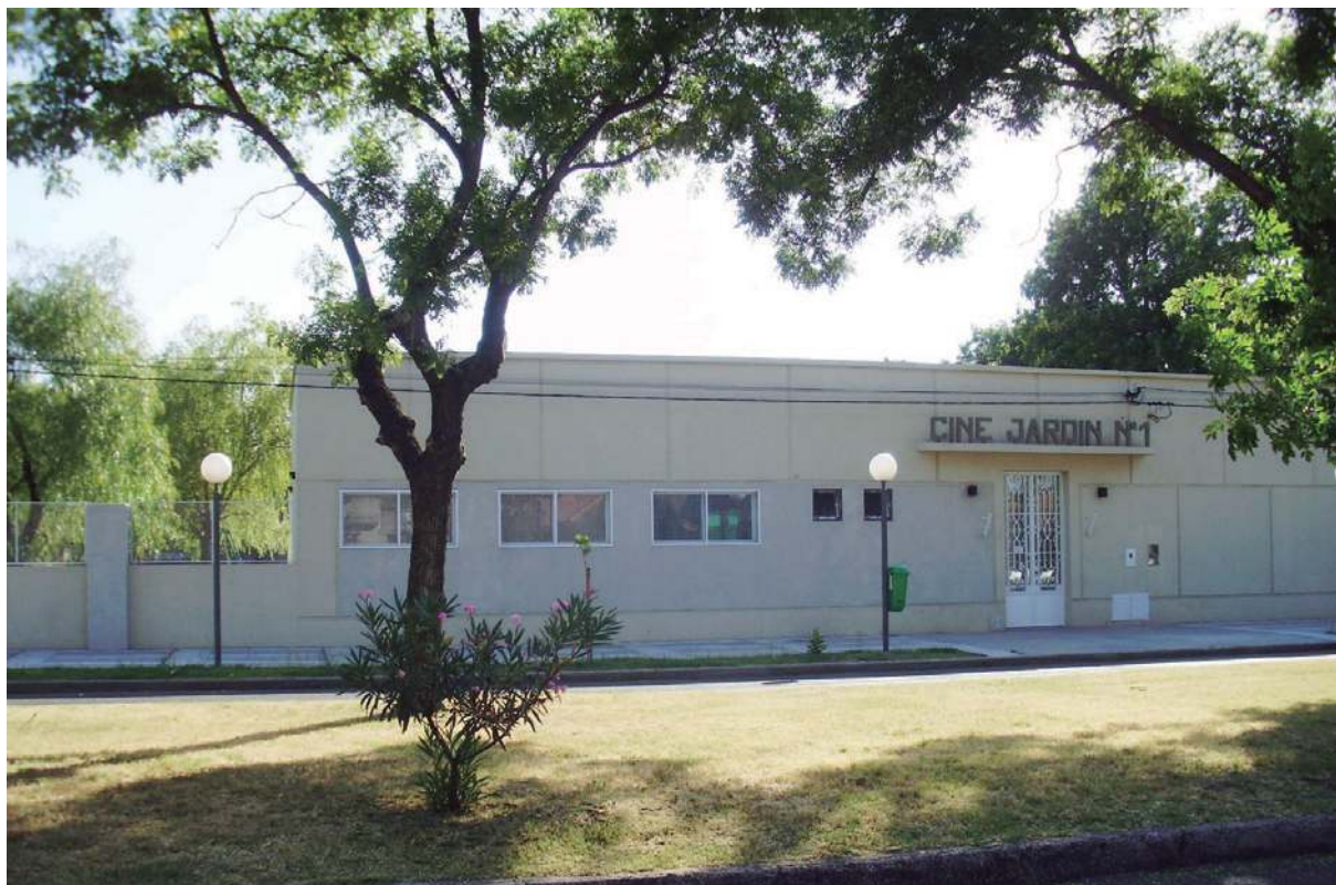
Fachada remozada el antiguo cine.
