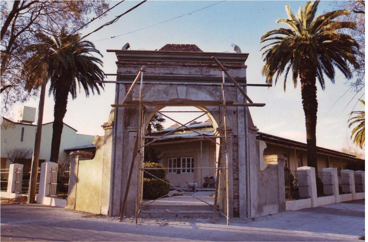
Arco de entrada en reconstrucción.
