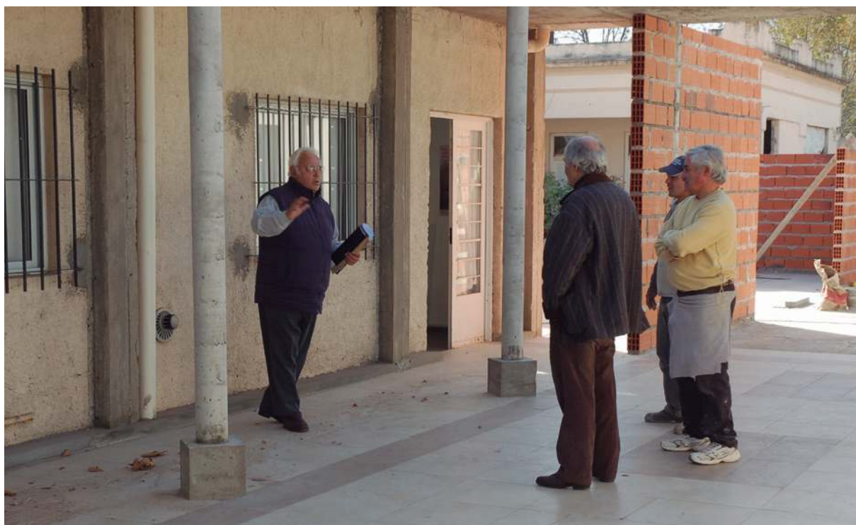
Centro de Rehabilitación en ejecución. El Intendente recorriendo la obra junto al Secretario de Planeamiento, Arq. Prieto, 2010.
