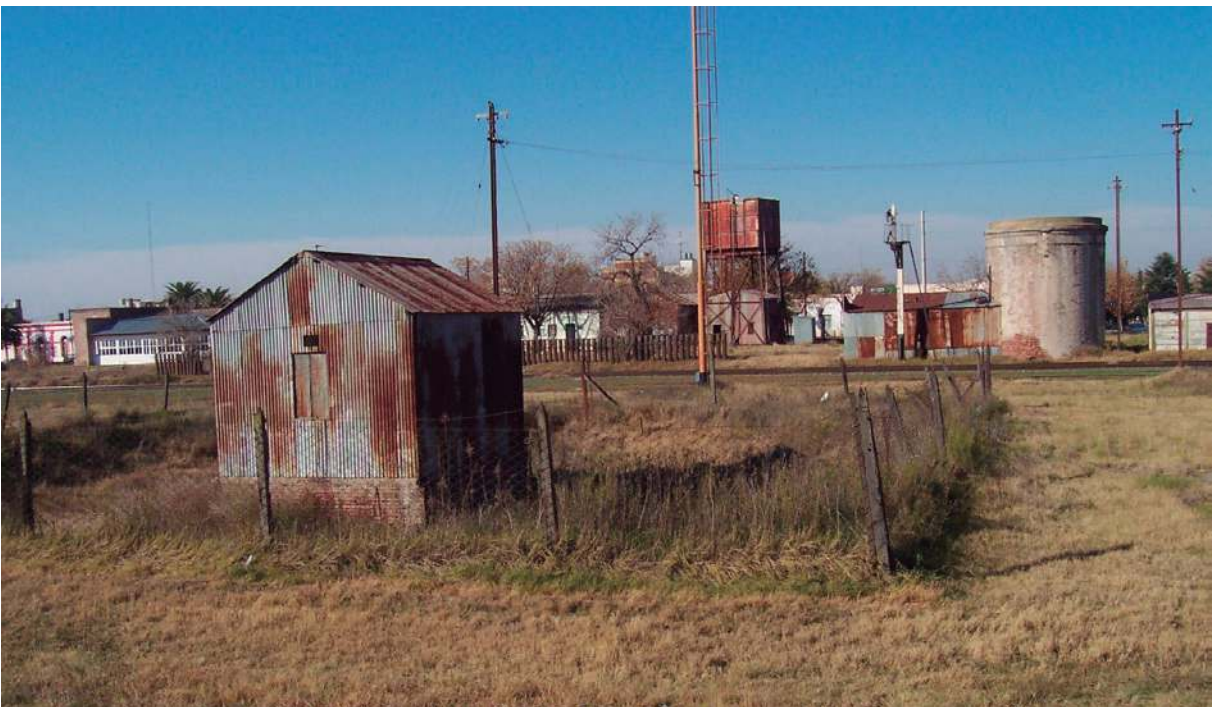
Vista de casilla demolida y torre circular ahora embellecida con una fuente.
