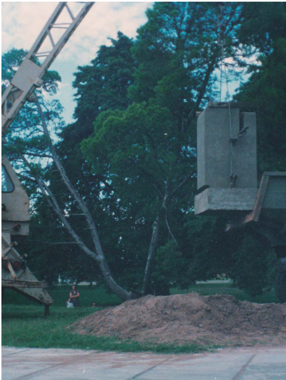
Descarga del basamento.
