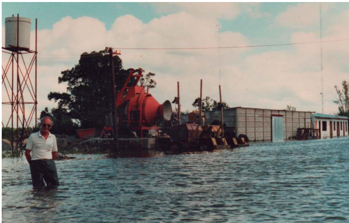
El Ing. Salinero de la empresa constructora del Barrio Democracia, junto al obrador el año 1987.
