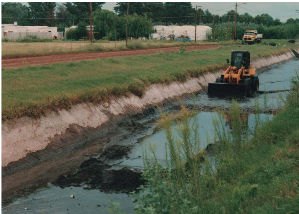
Dragado de pluviales, 1997.
