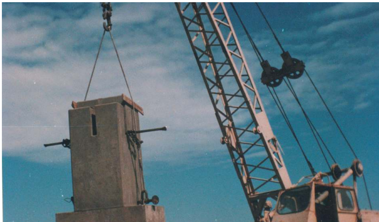
Grúa del Sr. Delfino, utilizada para colocar el basamento en su lugar de implantación.
