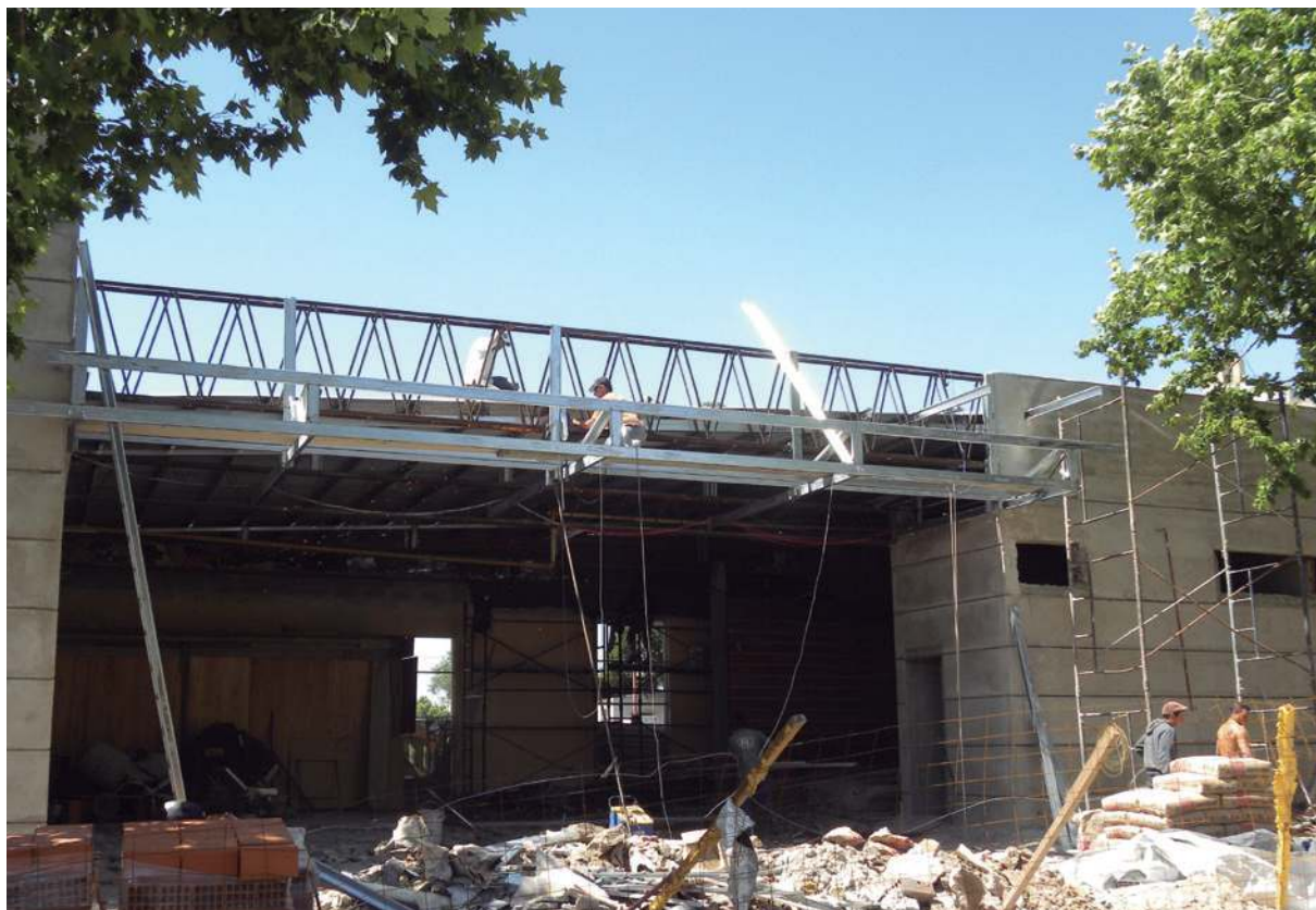
En plena tarea de remodelación de la estación Terminal de Ómnibus.
