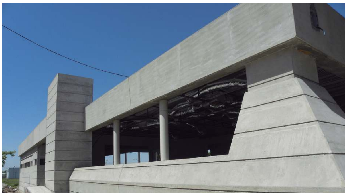
En plena tarea de remodelación de la estación Terminal de Ómnibus.
