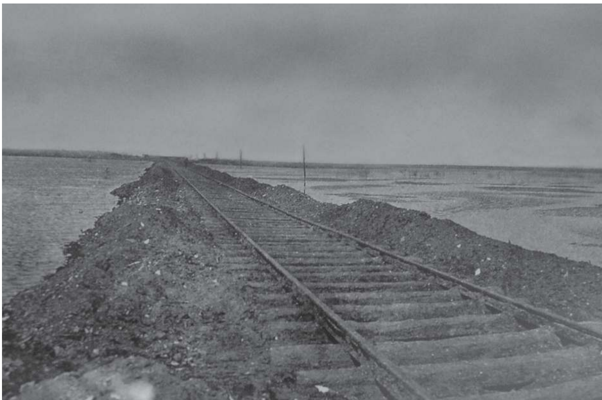
Taludes de contención para las vías férreas.
