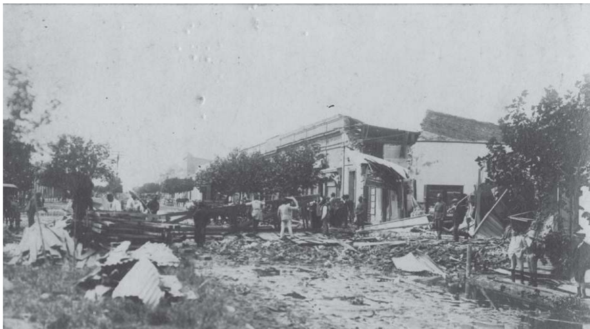
Imagen de los destrozos provocados por del ciclón.
