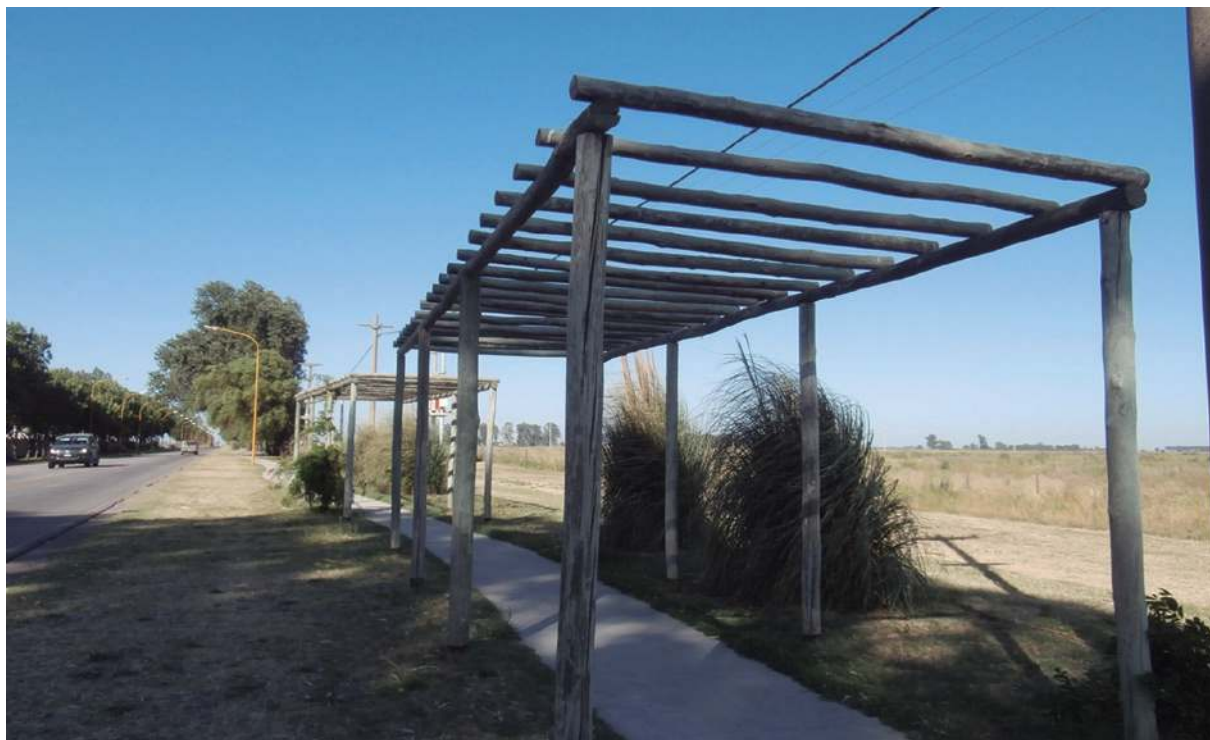
Acceso a la Ruta Nacional Nº 33 luego de su remodelación.
