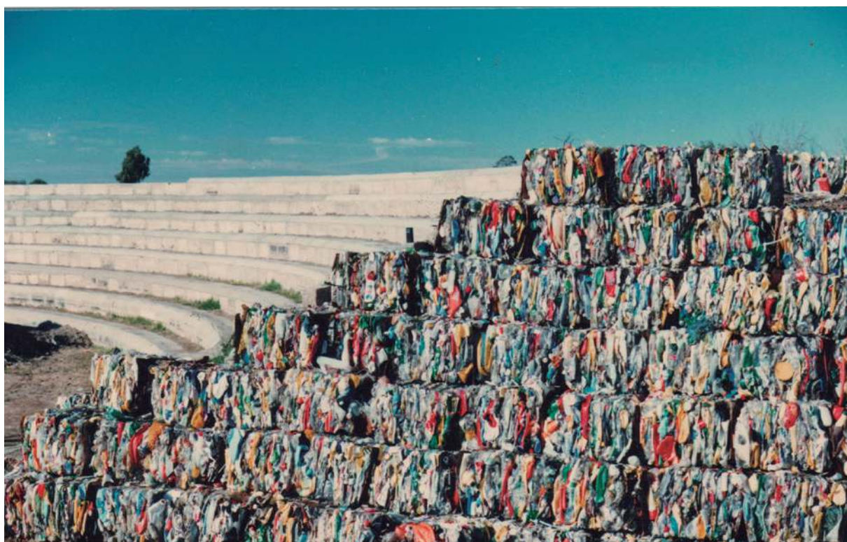
En plena ejecución el anfiteatro del Parque Municipal sobre un basamento de material plástico no reciclable.
