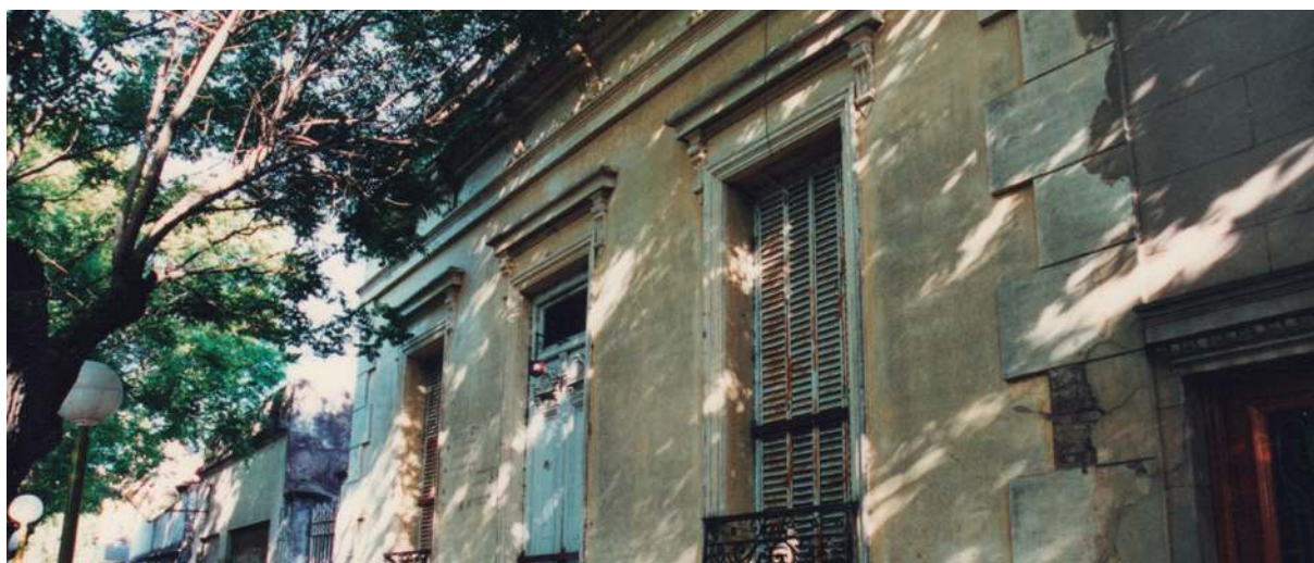
Frente antes de la restauración, año 2000.
