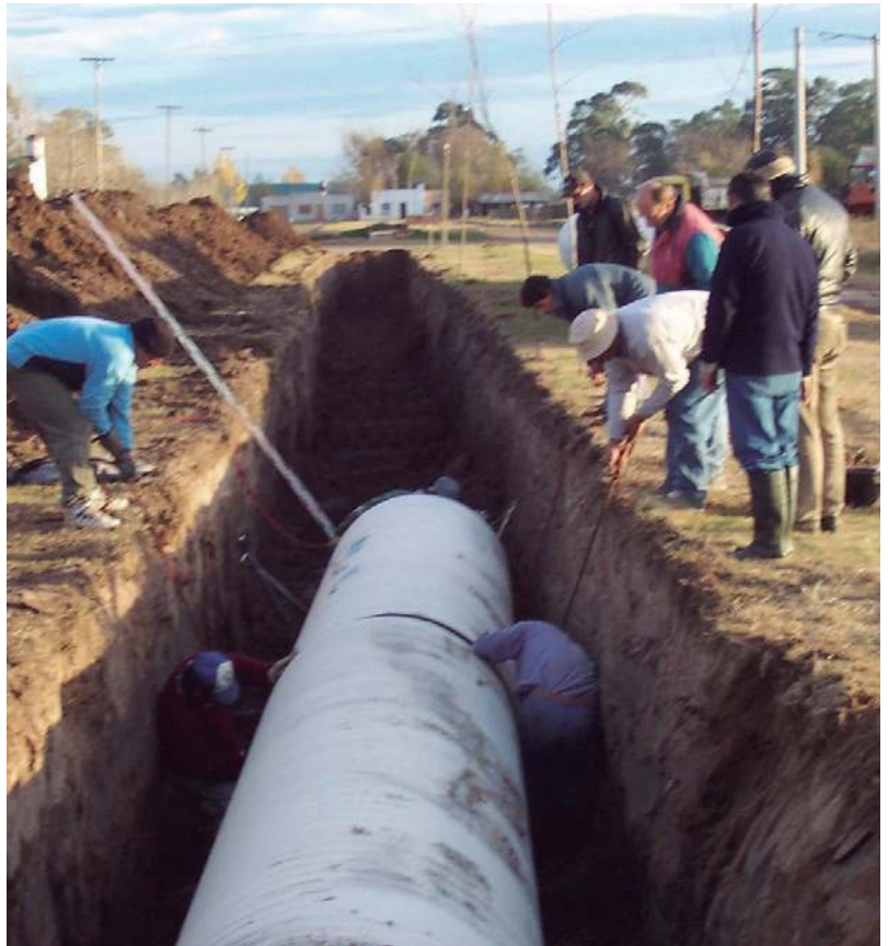
Tendido de conductos pluviales.
