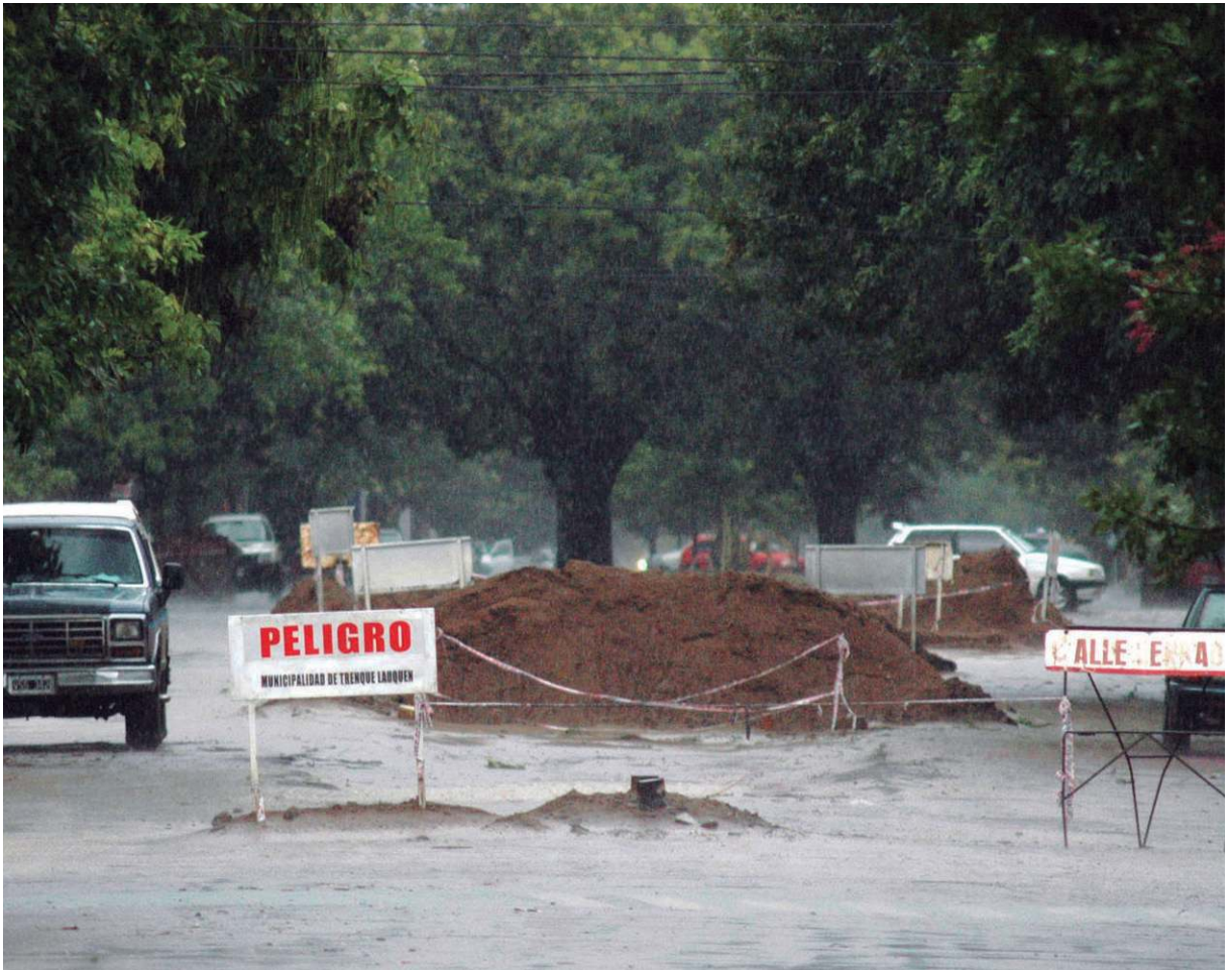
Calle Uruguay antes de solucionar problemas de inundación.
