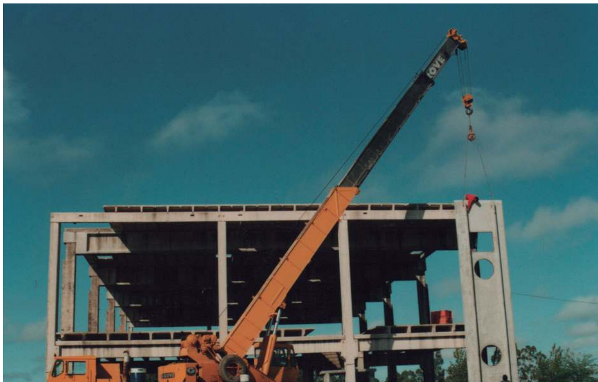
Grúa durante el montaje del cerramiento del Polideportivo.
