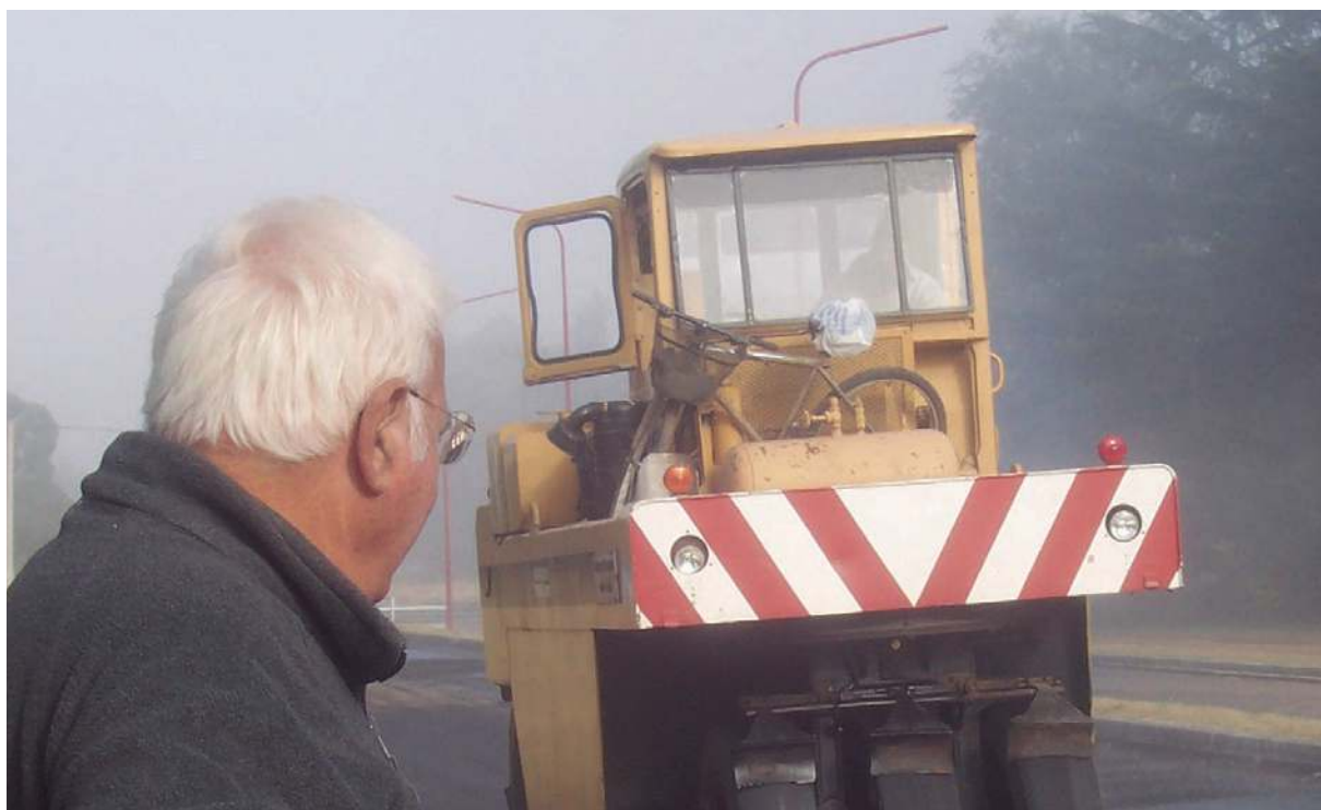
Jefe Comunal controlando las tareas de asfalto de la ciudad.
