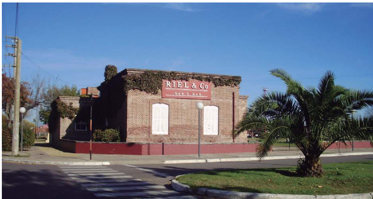
Local que recuperó el edificio.
