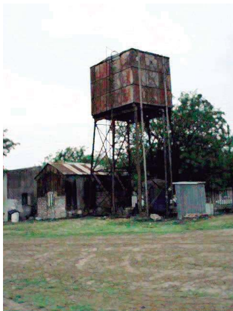
Antiguo tanque de agua.
