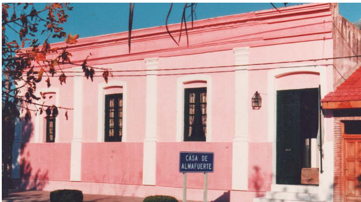
Frente del edificio restaurado, declarado Monumento Provincial por el Senado de la Provincia de Buenos Aires.
