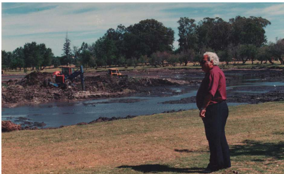
Recuperación del Parque Municipal, el Intendente controla las obras de dragado, 1994.
