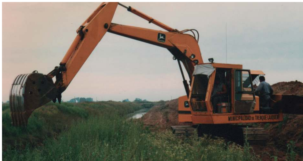
Retroexcavadora dragando canal pluvial.
