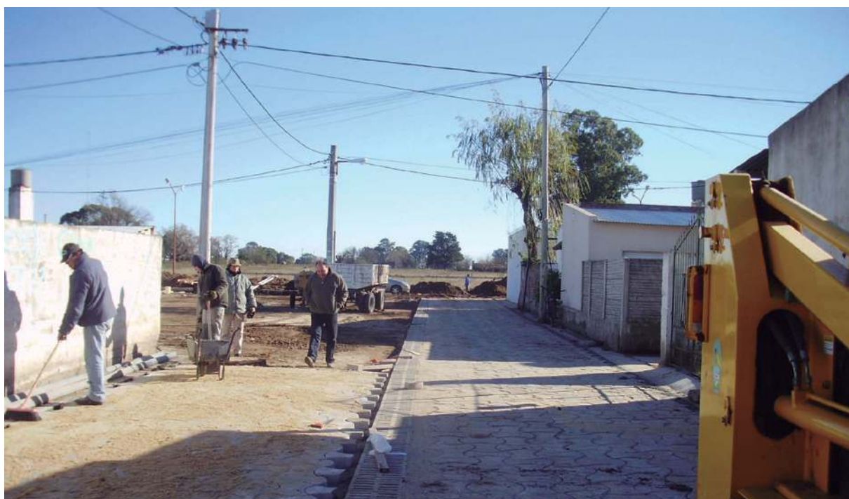
Ejecución de la nueva calle del barrio.
