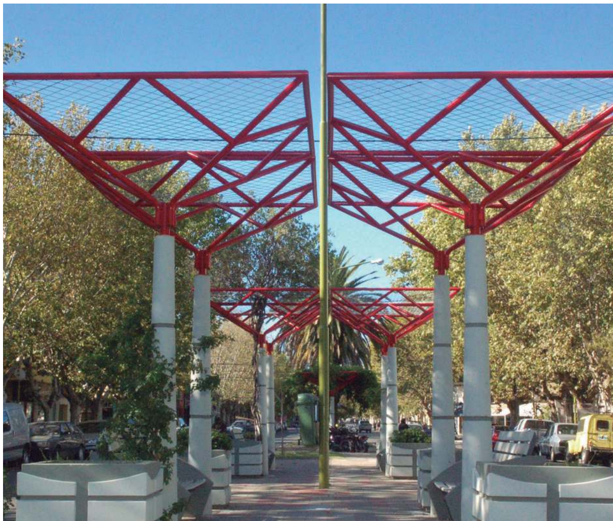
Imagen de la renovación de la Avenida principal.
