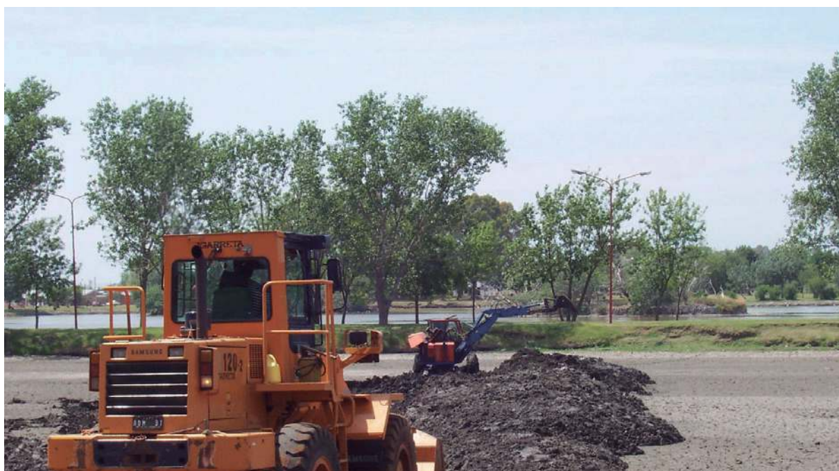
Terraplenes de avance para poder entrar la máquina dragalina en la laguna.
