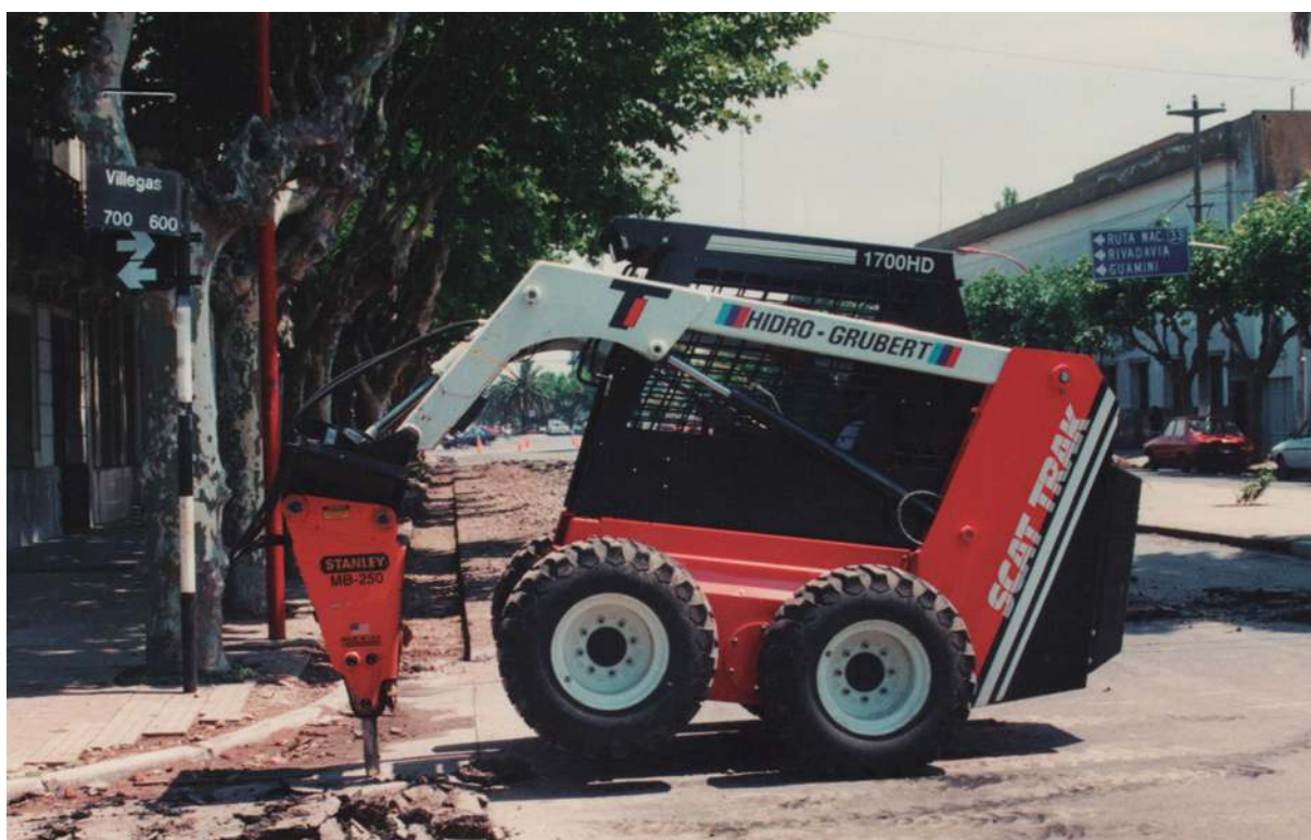
Ejecución del cordón cuneta de todo el casco urbano, marzo de 1995.
