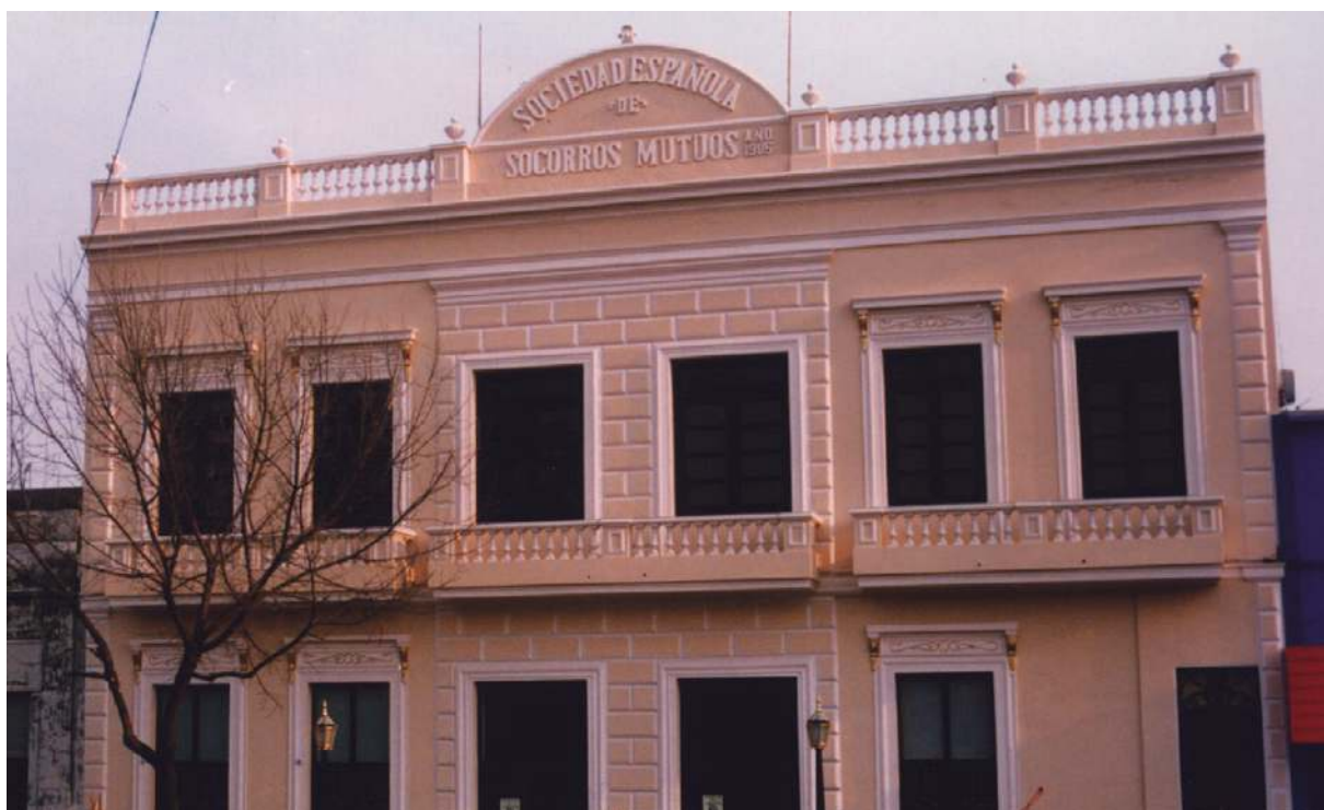
Fachada del Teatro restaurada.
