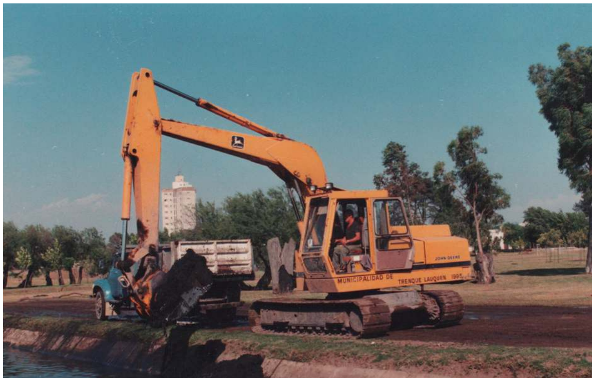
Dragado del sector del canal revestido del Parque Municipal.
