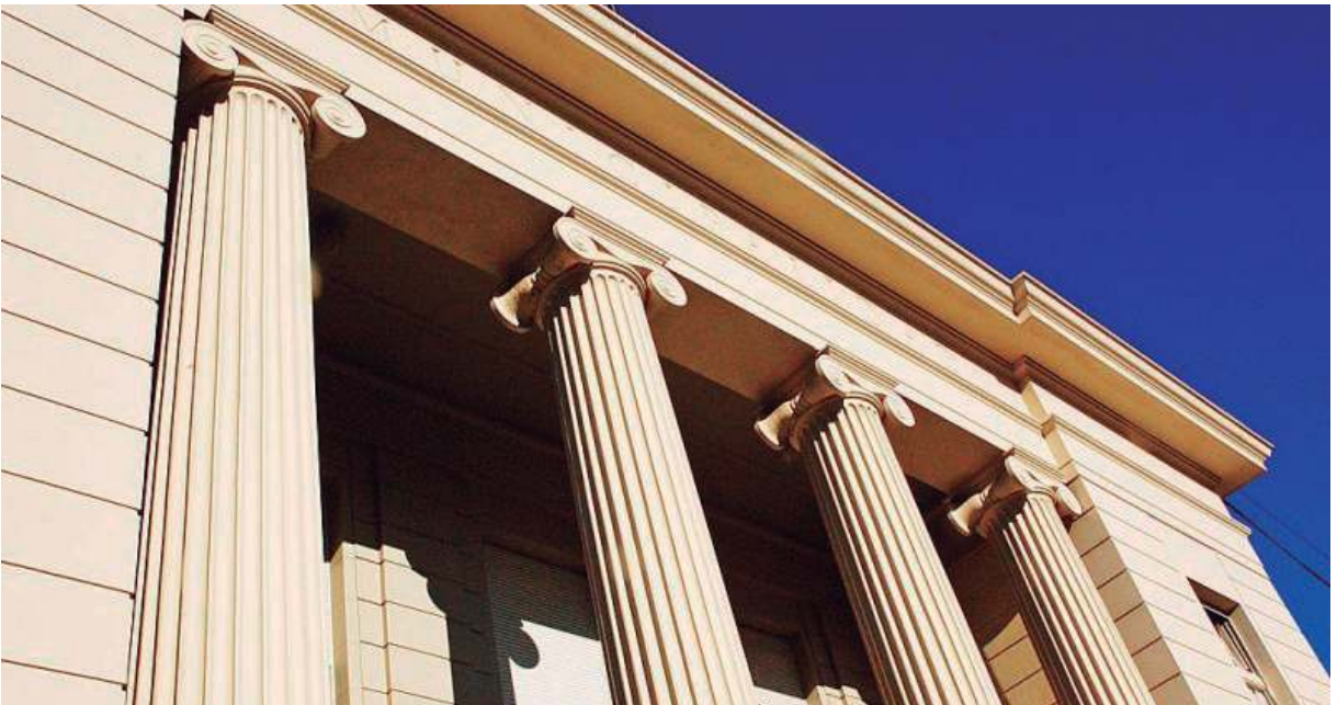
Acercamiento a las columnas.
