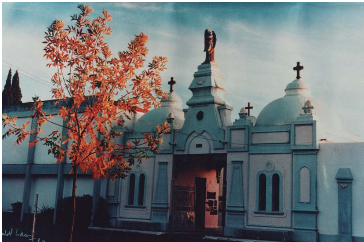
Portal restaurado y pintado, década de 1990.
