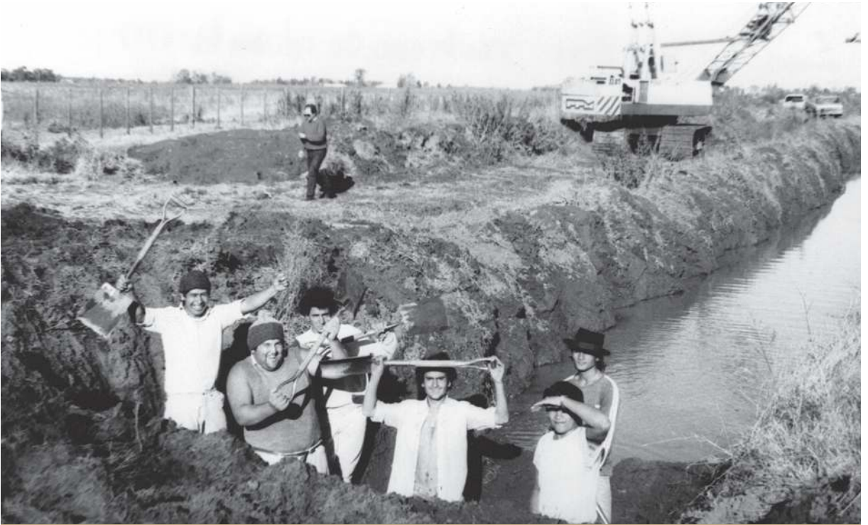
Los "Tello's boys" reubicando alcantarilla del canal.
