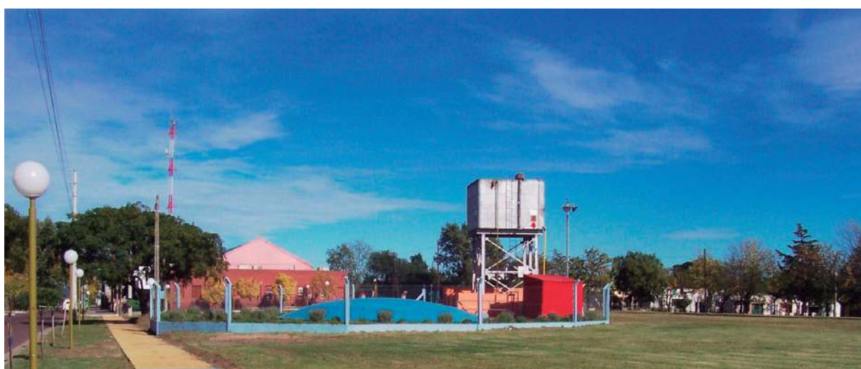
Tanque después de finalizadas las obras.
