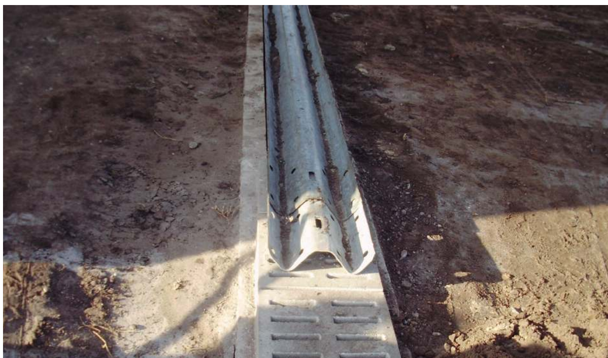
Detalle del desagüe del barrio.
