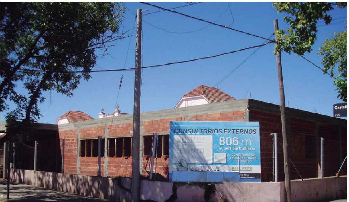
Ampliación de consultorios externos en el Hospital Municipal, 2012.
