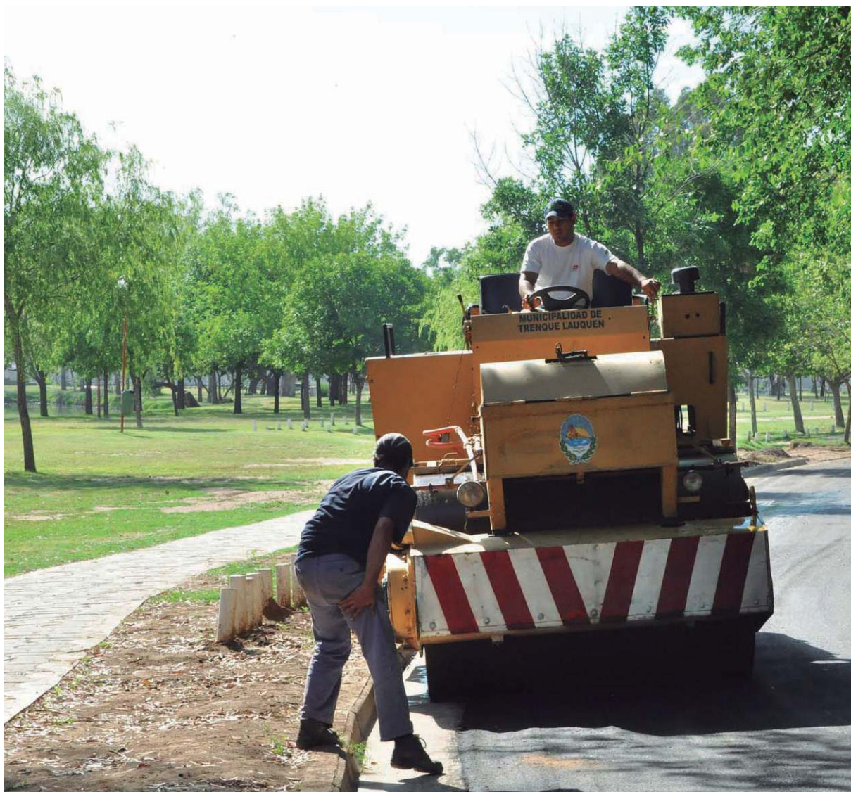
Trabajos de pavimentación y cordón cuneta en el Parque Municipal.
