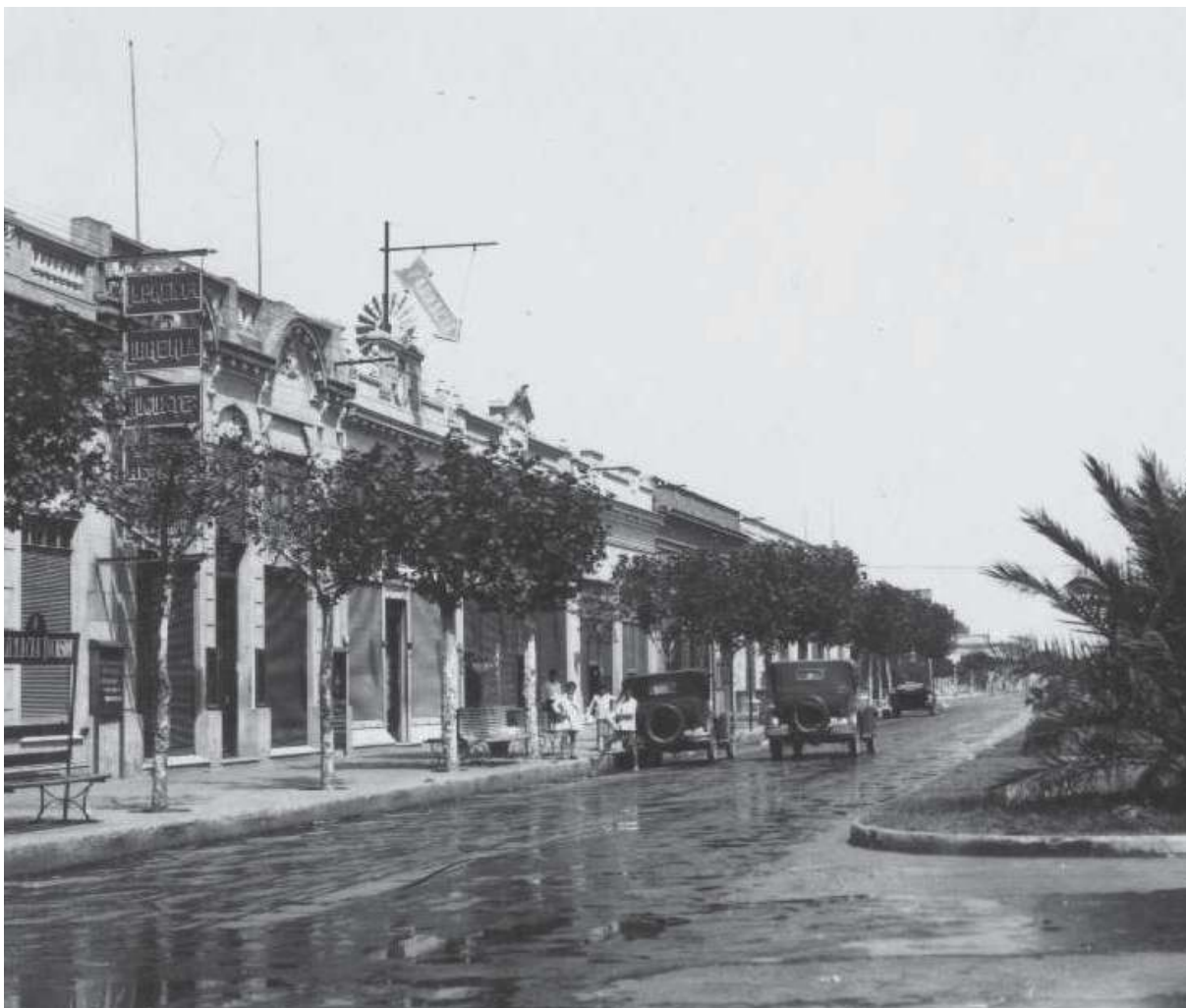
Boulevard Villegas donde ya estaban las palmeras en puntas de rambla.
