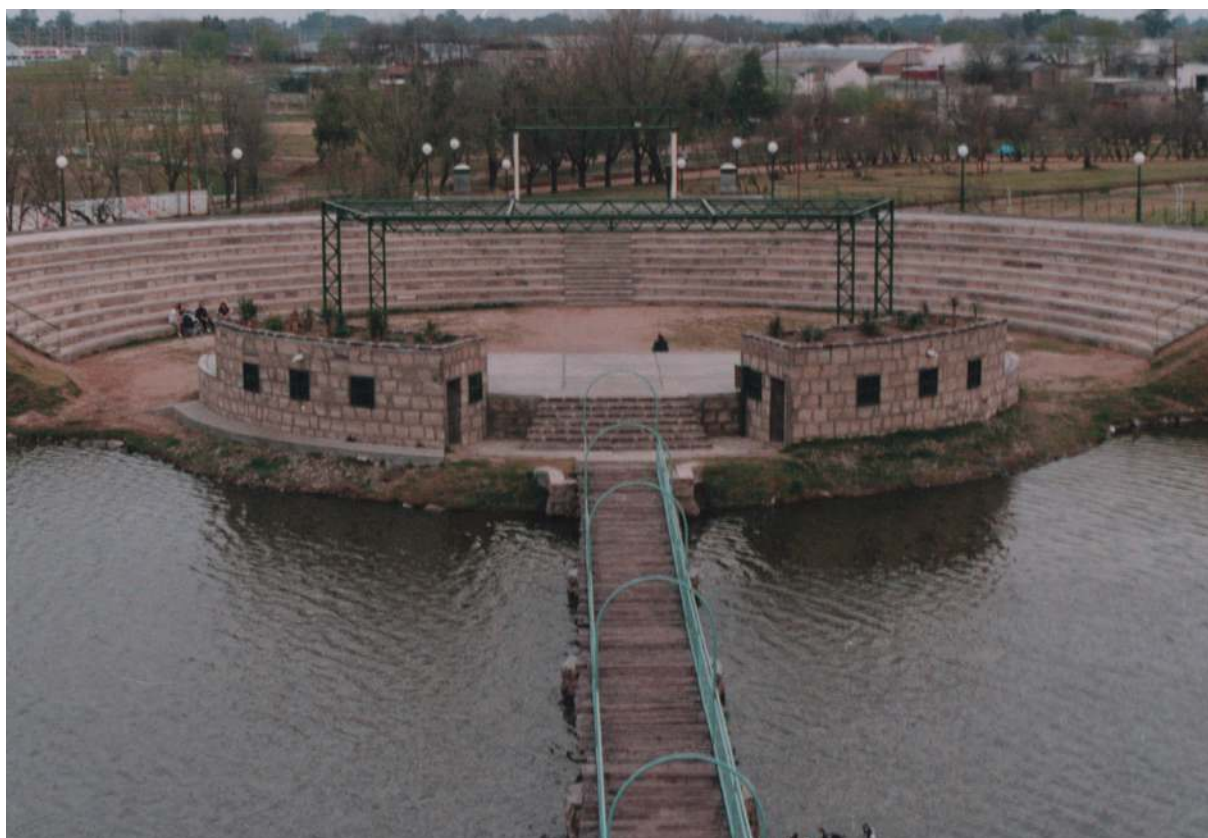
Puente sobre la laguna hacia el anfiteatro.
