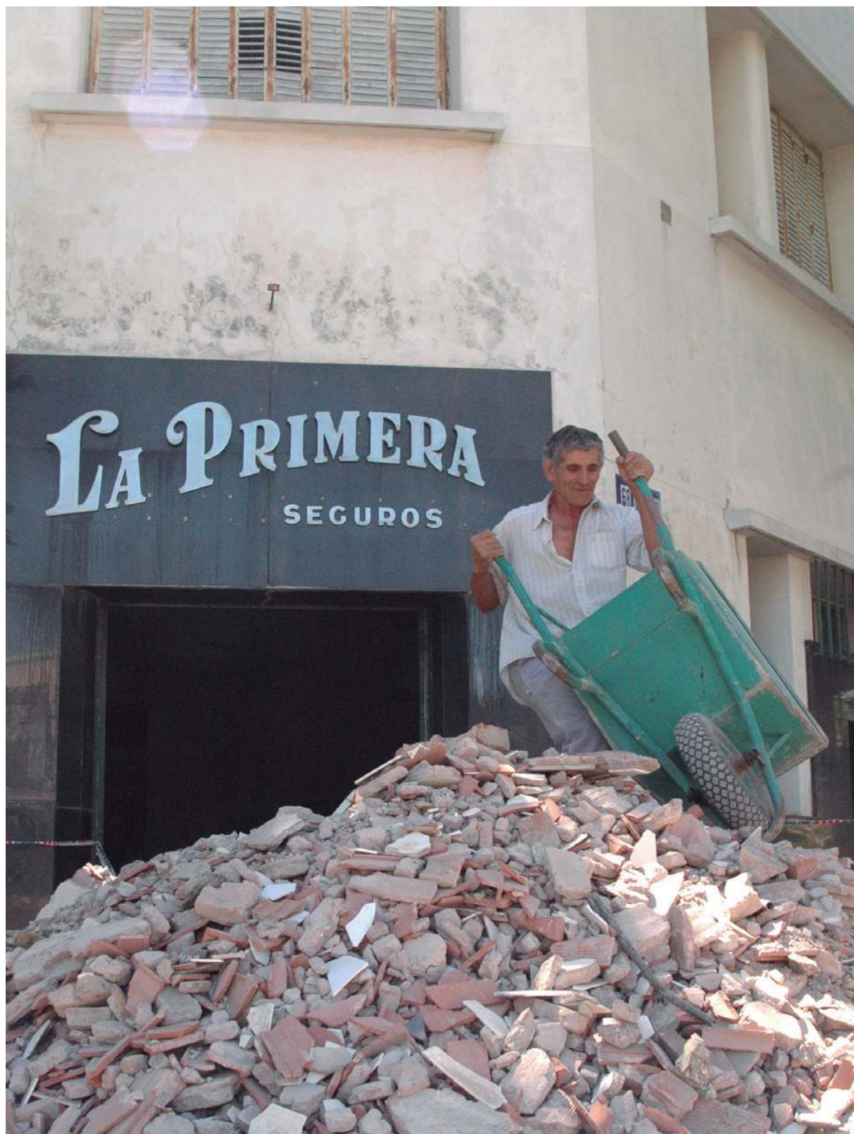
Primeras labores de limpieza y demolición.
