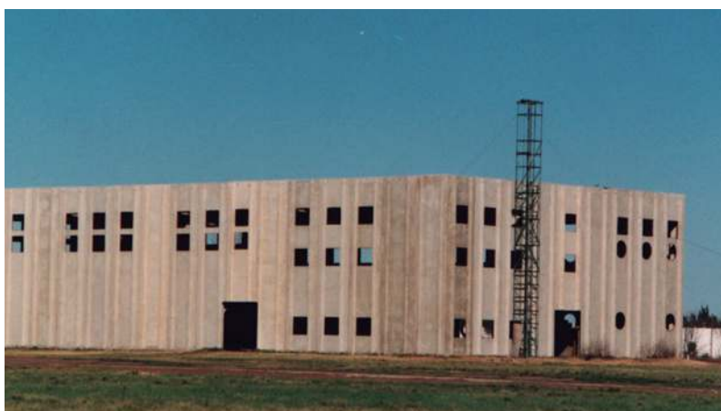
Montaje terminado. abril de 1995.
