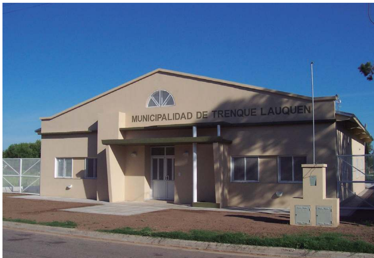
Nuevo salón de usos múltiples.
