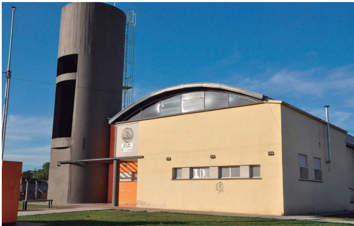
Acceso nuevo edificio comunitario del Barrio Villegas.
