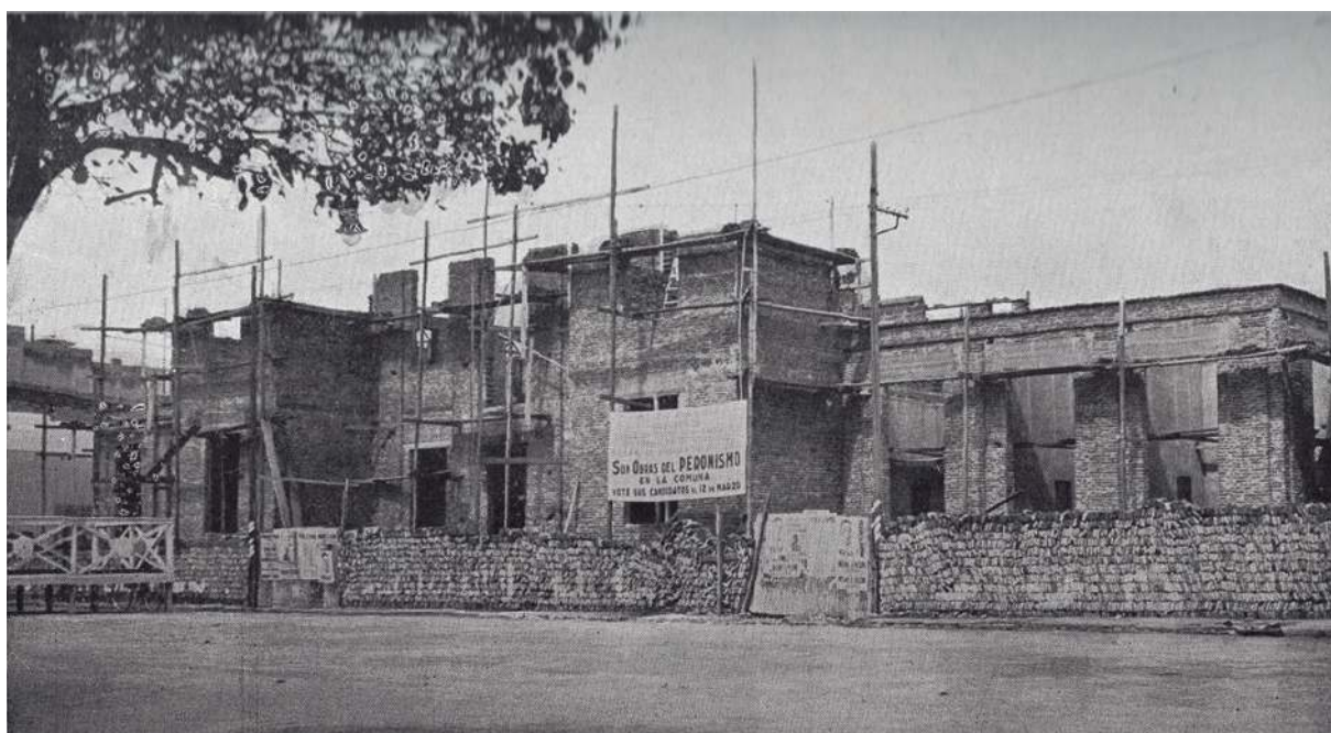
Construcción del nuevo edificio del Municipio, 1950.
