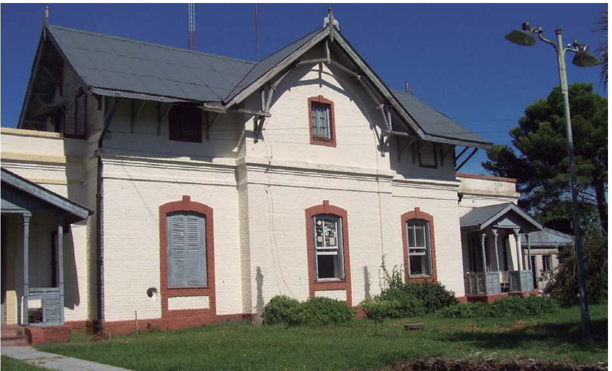
Vivienda de técnicos en primer plano, atrás oficina de Vías y Obras.
