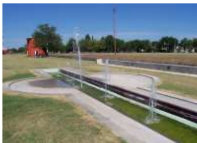
Fuente de agua, predio ahora recreativo, Arq. Carlos Marino.
