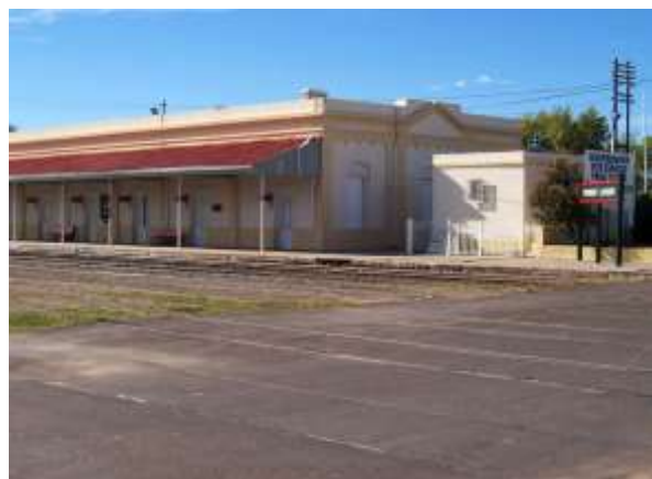
Frente Estación totalmente recuperada, 2005.
