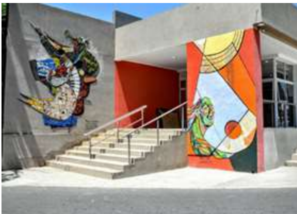
Fachada de la Escuela de la Música, muro izquierdo, 2017.
