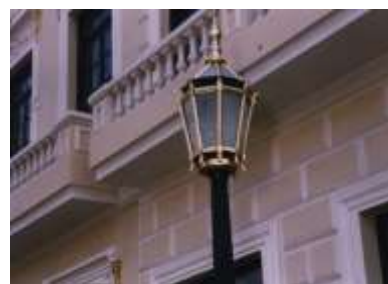
Detalle de una farola restituida del frente a su fachada.
