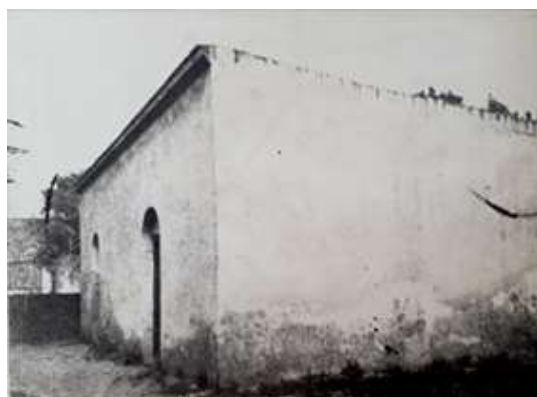
Era ladrillo visto, revoque añadido por rigor climático. (Ver: foto antigua 1889, Capítulo 3).
