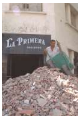
Inicio de la demolición parcial.
