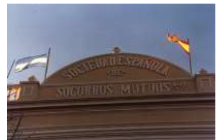
Arco rebajado reconstruido según antiguas fotografías.
