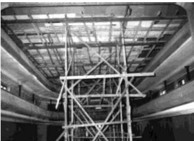
Andamiaje armado exclusivamente para facilitar la pintura en altura del cielorraso.
