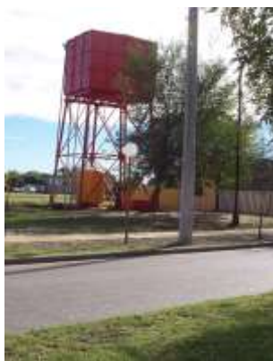
Tanque de reserva de agua, en el año 2005.
