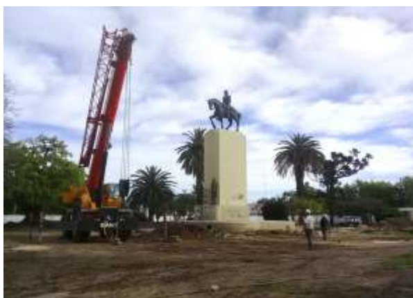
Desplazamiento del monumento, la empresa no cobró honorarios por esta labor.
